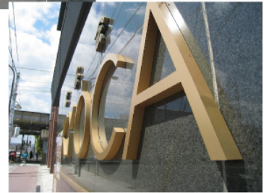
◀御影石パネルに設置した箱文字サイン
