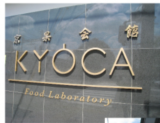
◀御影石パネルに設置した箱文字サイン
