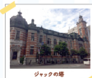
ジャックの塔
