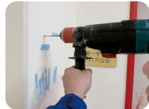
まずは位置出しをします。位置出しで、穴を開ける位置に印をつけ、次にφ5の大きさの穴をインパクトドライバーで空けていきます。
