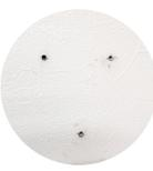
壁面に穴が開いたら、壁の材質がボードのためボードアンカーを打っていきます。ボードアンカーが入れば、次にスライドロックベースを取り付けます。
