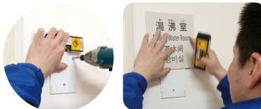
固定したら、再度水平器を用いて調整します。調整した後、表示基板をいよいよスライドロックベースに、はめ込んで完成です！
