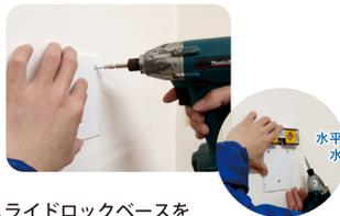
スライドロックベースをビスで仮止めをし、水平器を用いて水平を計りながら、固定していきます。
