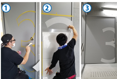
↑原寸原稿をあてて、取付位置に穴あけをします。
